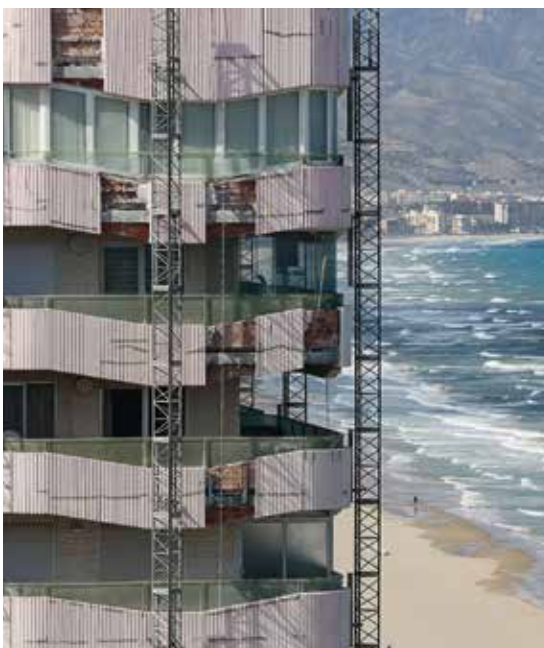
Torres Blanca, Alicante (Espagne) ; Protection au MasterProtect 8000 CI (inhibiteur de corrosion)
